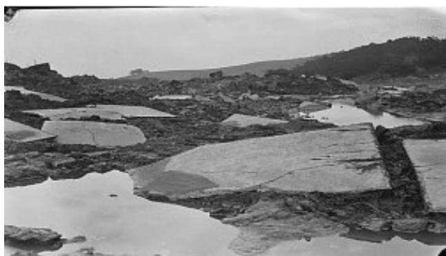
Figure I-8 : Rupture du barrage de Sheffield après le séisme, Santa Barbara, 1925 [12]
