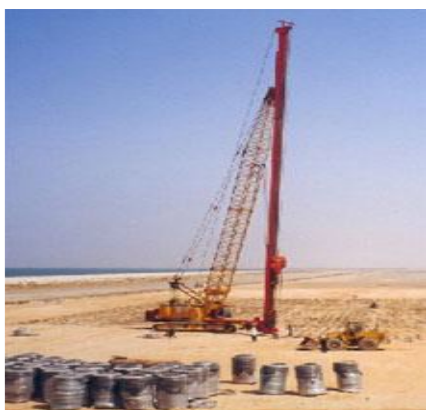
Figure II-26 : Drains verticaux
