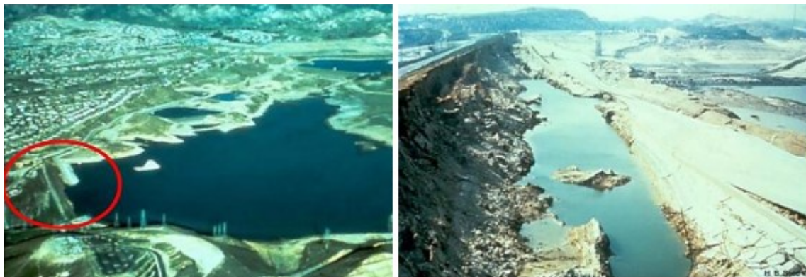
Figure I-7 : Barrage de San Fernando avant et après le séisme de 1971 [11]
